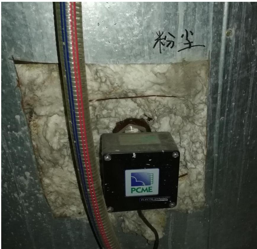
照片2 烟气在线监测装置（粉尘仪）
